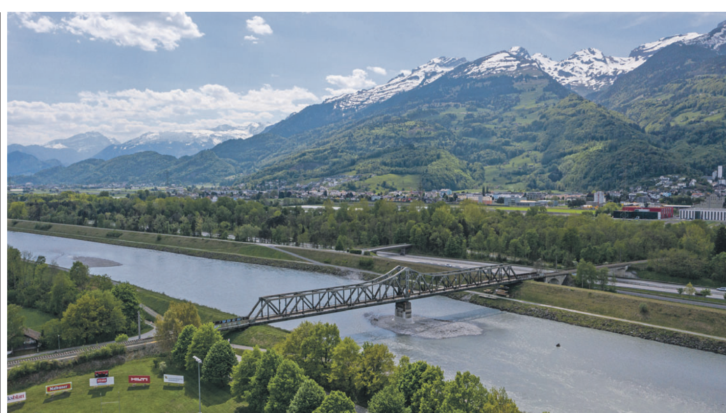
1927 kam es zur Katastrophe, als der Rhein den Damm oberhalb der Eisenbahnbrücke wegspülte. Der Schaden lag damals bei 10 Millionen Franken – dies entspricht mittlerweile 65 Millionen. Aufgrund der stärkeren Besiedlung wäre der Schaden heute aber wohl nur schwer zu beziffern. (Foto: Michael Zanghellini)
